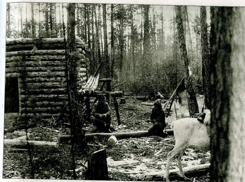
Рис. 56. Строительство зимней избушки. 1989.
