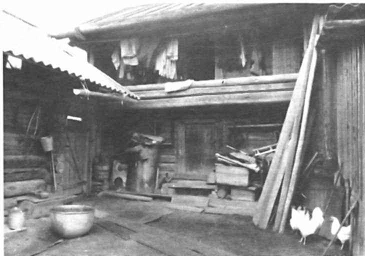
Фото 2. Двухэтажный амбар кенос. 1990 г. д. Жувам, Юкаменского района. Фотоархив УРМИИ.
